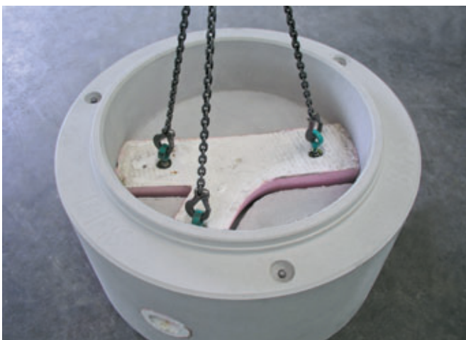
Ausheben des Gerinnes in einem Stück
